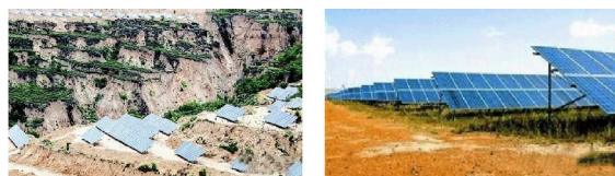
(a) 山西孝义全国首家采煤沉陷区光伏发电基地 (b) 霍林郭勒市矿山排土场光伏发电项目
