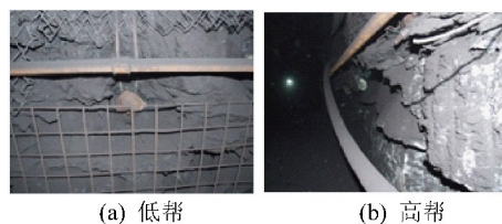
图11 石炭井二矿现场巷道的变形破坏
