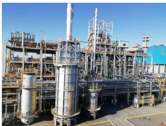
图 51 10 万 t/a 高温费托合成工业示范装置
