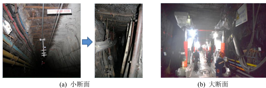
图29 小断面和大断面沿空巷道支护效果
