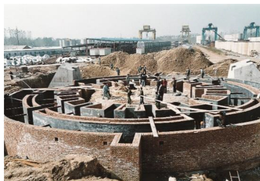
图 44 矿井冻结工程配集液圈施工现场
