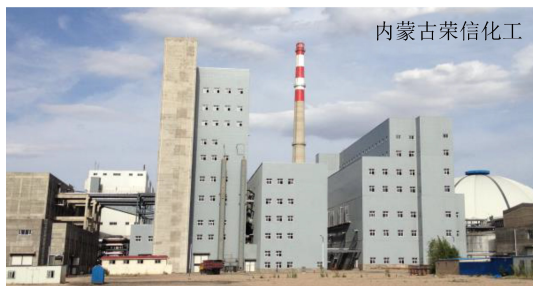
图53 单炉日投煤3 000 t的水煤浆气化工业装置
