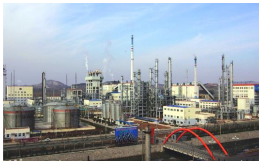
图52 日投煤1 150 t新型水煤浆气化炉
