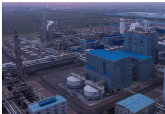
图54 单炉日投煤4 000 t的水煤浆气化工业装置
