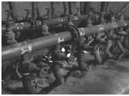
图 6 钻场排水排渣管路连接
