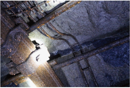
(b) 钢筋梯被挤压变形
