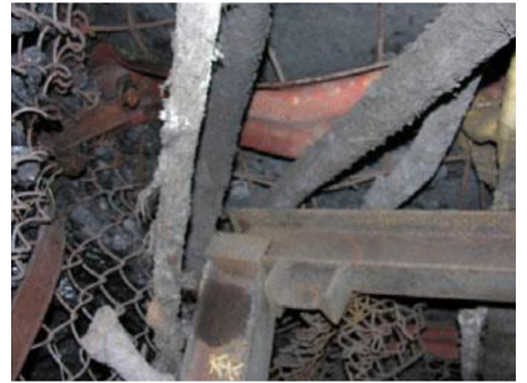
图1 淮北矿区桃园煤矿受水侵蚀顶板支护失效 [11]
