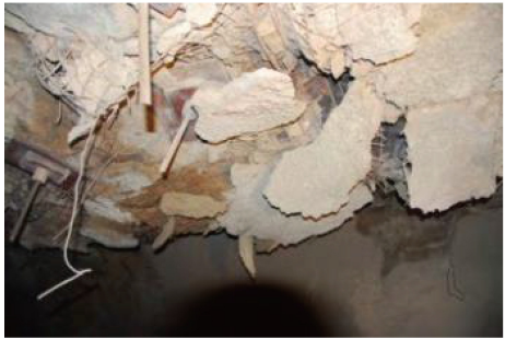
(b) 喷层大面积开裂、剥落
