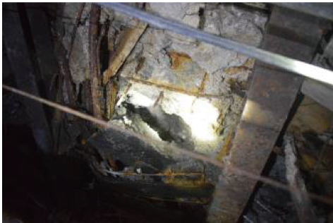
(b) 支护体腐蚀
