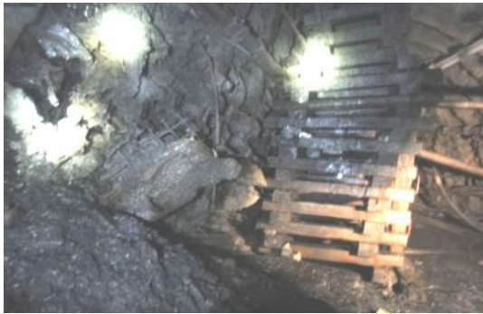
图 21 泥化巷道全断面失稳 [89]
