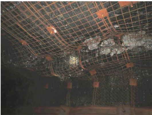
图7 掘进期间围岩及支护破坏实照 [29]
