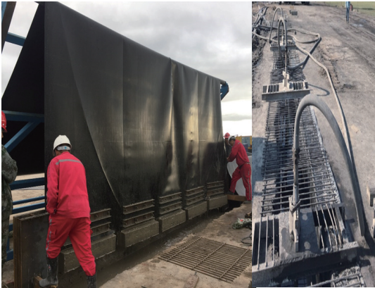
图 4 扎尼河露天矿防渗膜帷幕示意
