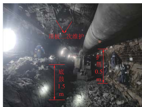
(a) 变形破坏照片
