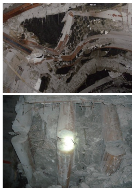
图 10 典型弱胶结地层巷道变形破坏形态
