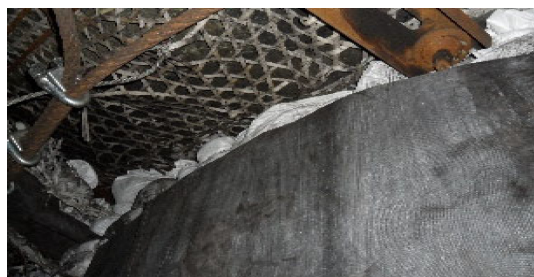
图9 挂绳上网配合风筒布施工
