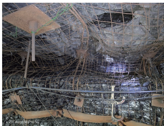
图 15 强冲击载荷引起巷道变形破坏照片
