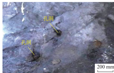
图 3 巷道揭露 9-6 陷落柱空洞发育情况
