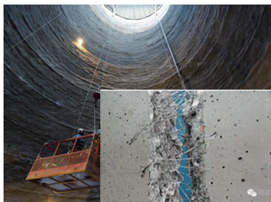
图7 纤维混凝土二衬结构
