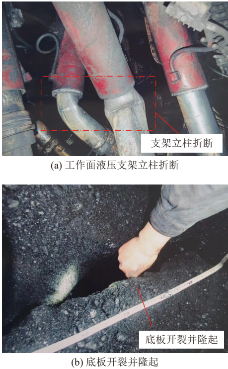
图 1 5521-20 综放工作面“3·24”冲击地压现场事故照片 Fig.1 5521-20 fully-mechanized top-coal caving face “3·24” rock burst accident scene photos
