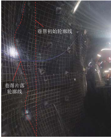
图 4 巷道掘进工作面附近片帮现场
