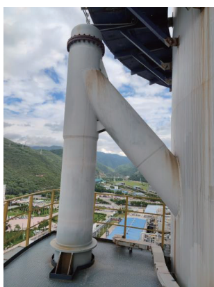
图6 现场缓冲管和管帽的实物
