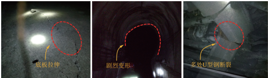
图 3 现场变形破坏
