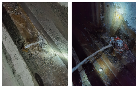
图11 骆驼山煤矿缓坡斜井井筒渗漏水
