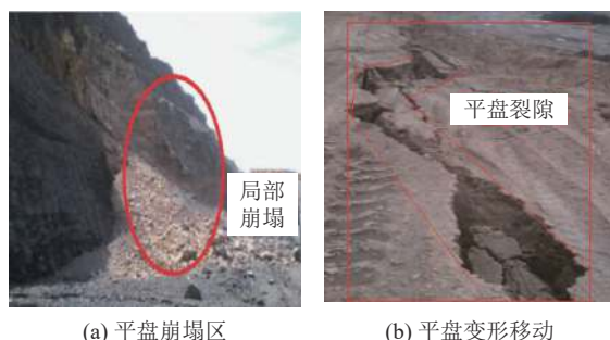
图 27 边坡平盘局部滑移及移动
