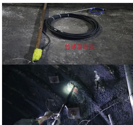
图 11 应变传感光缆安装
