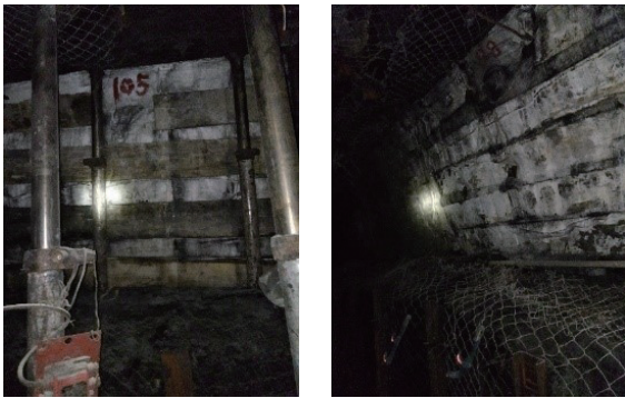
图 13 巷旁充填墙体井下施工
