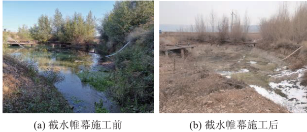
图 9 磁吸防渗膜垂向帷幕效果对比
