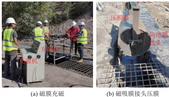
图 6 磁吸防渗膜充磁及接头压膜
