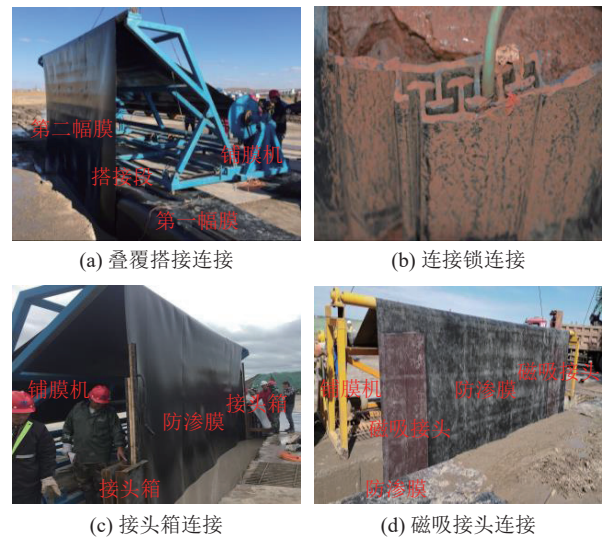
图 2 防渗膜接头连接工艺示意
